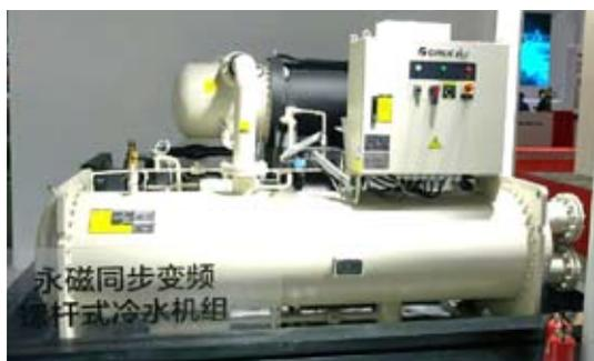
图2-22 格力永磁同步变频螺杆式冷水机组
