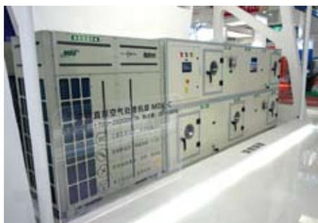
图2-36 麦克维尔变频直膨空气处理机组
