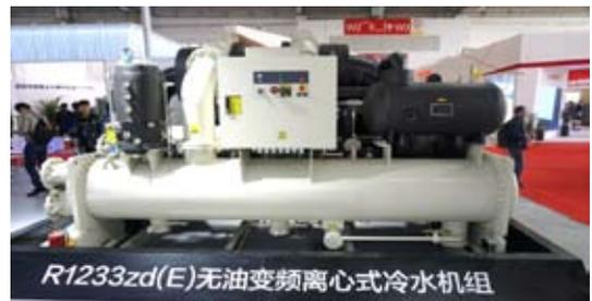
图2-20 格力R1233zd(E)无油变频离心式冷水机组
