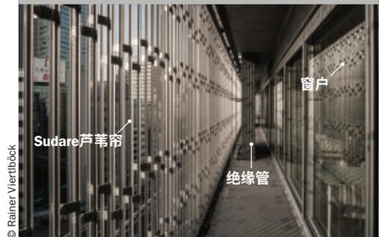
帘幕为外部安装的机械设备营造了一个安全的围护空间，甚至还起到了闪电保护的作用。总的来说，花一份钱可以得到六种功能(立面外观、遮阳、反射日光、维护阳台、维持视野、防闪电)。
