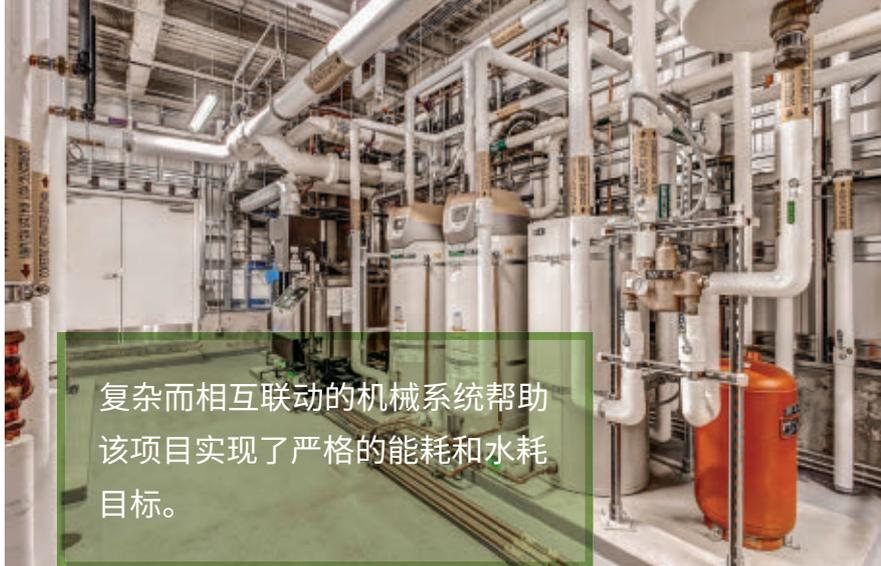
复杂而相互联动的机械系统帮助该项目实现了严格的能耗和水耗目标。
