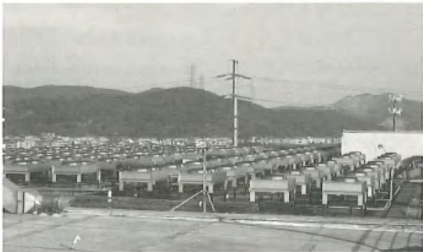
图 3.6-8 某数据中心室外机集群安装现场
