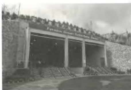
图 1.1-6 富士康绿色隧道数据中心
