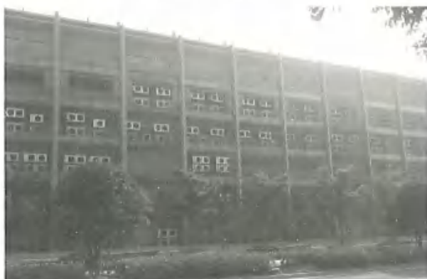
图 3.6-5 某运营商数据机房设计了风冷冷凝器专用阳台
