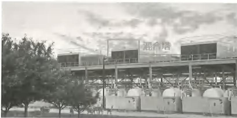
图 5.7-6 谷歌冷却模块的现场实景
