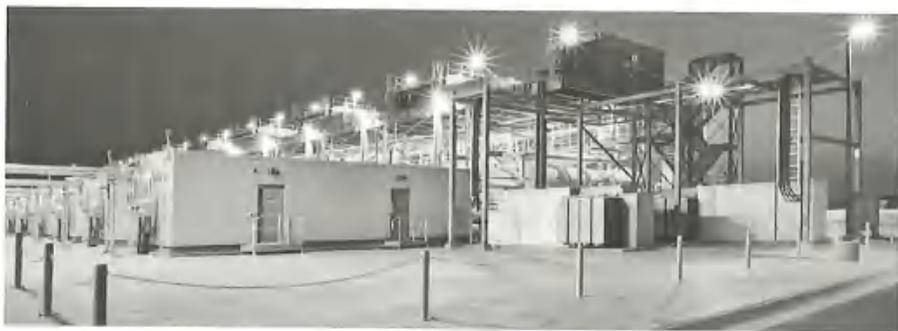
图 5.7-3 带冷水机组的制冷系统模块化阵列
