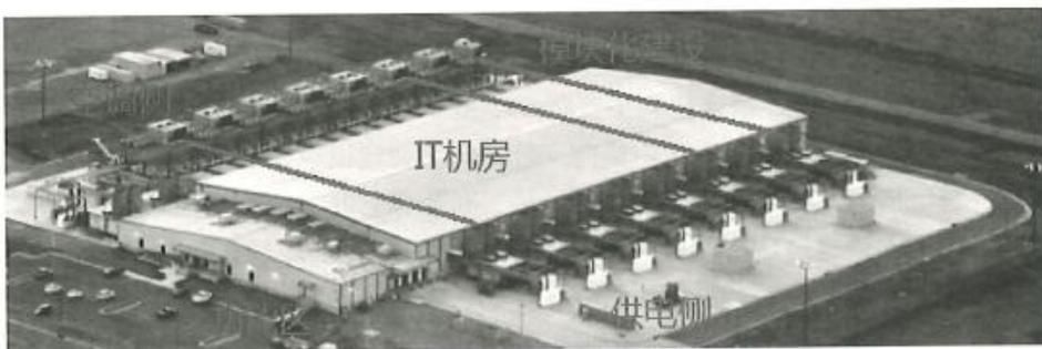
图 5.7-11 谷歌某个数据中心的外部模块化建设图片
