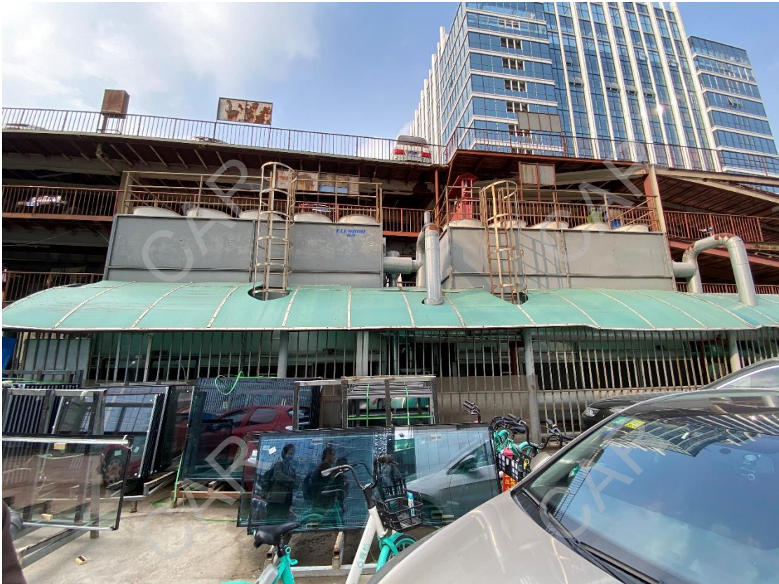
图 7-52 中科云数据中心室外环境
