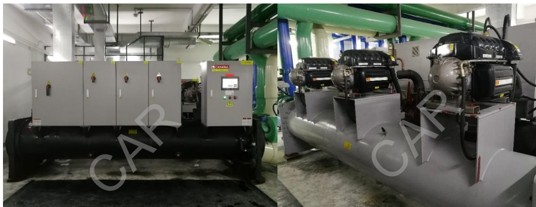
图 7-32 睿江云数据中心制冷机组
