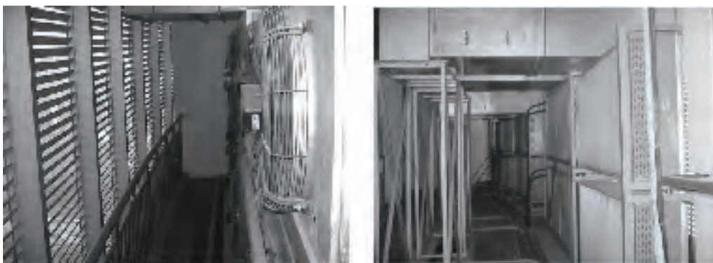
图 1.4-1 室外机安装实景
