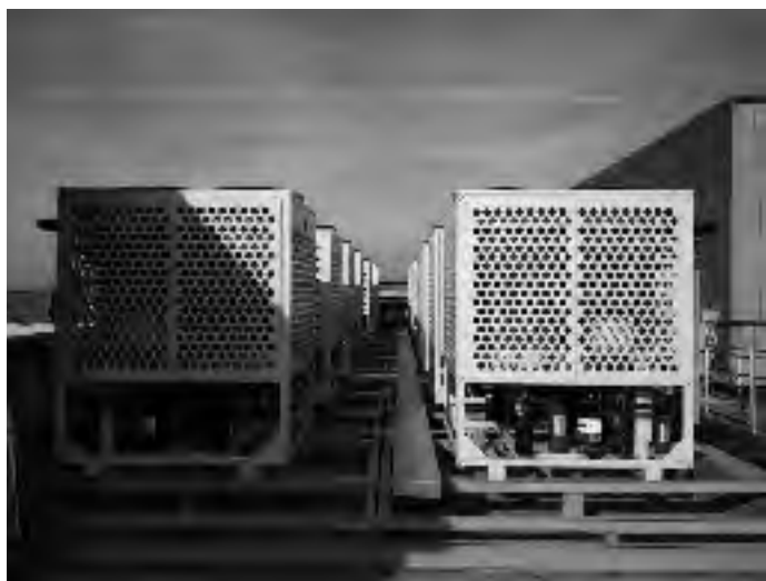
图 7.5-4 热管-蒸汽压缩复合一体机照片
