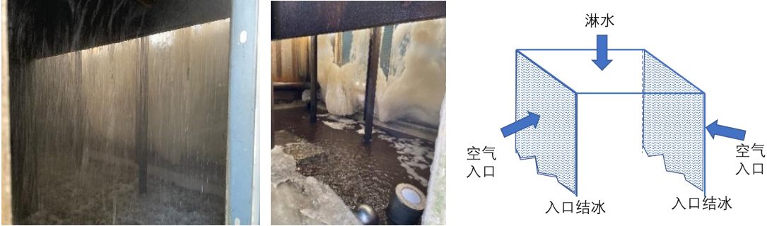
图 7. 冷却塔空气入口结冰现象
